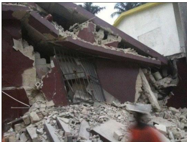
Fig. 1. Escenario urbano típico tras un terremoto. Entorno no estructurado y caótico, con escombros por todas partes. Ciudad de Puerto Príncipe, Haití. Foto cortesía de tumundovirtual.wordpress.com
